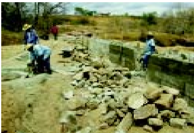
Construção de barragem sucessiva é uma das soluções para famílias agricultoras de Caraúbas - RN
